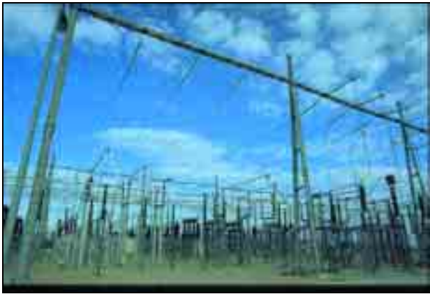
Tendido de líneas de luz eléctrica.
